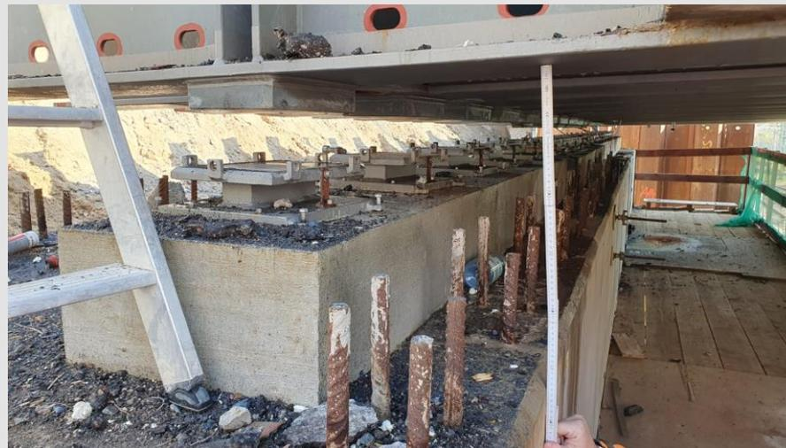
Östliches Brückenteil: Einhub der Verschubbahnen und Anheben des Brückenüberbaus, April 2024
